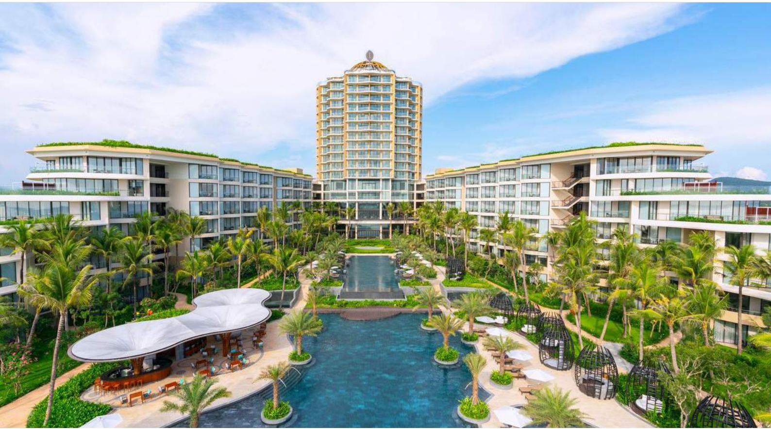
Dự án Intercontinental Phú Quốc - Kiên Giang - Cung cấp và lắp đặt cửa thép chống cháy kỹ thuật Quy mô: 9.190.000 m 2
