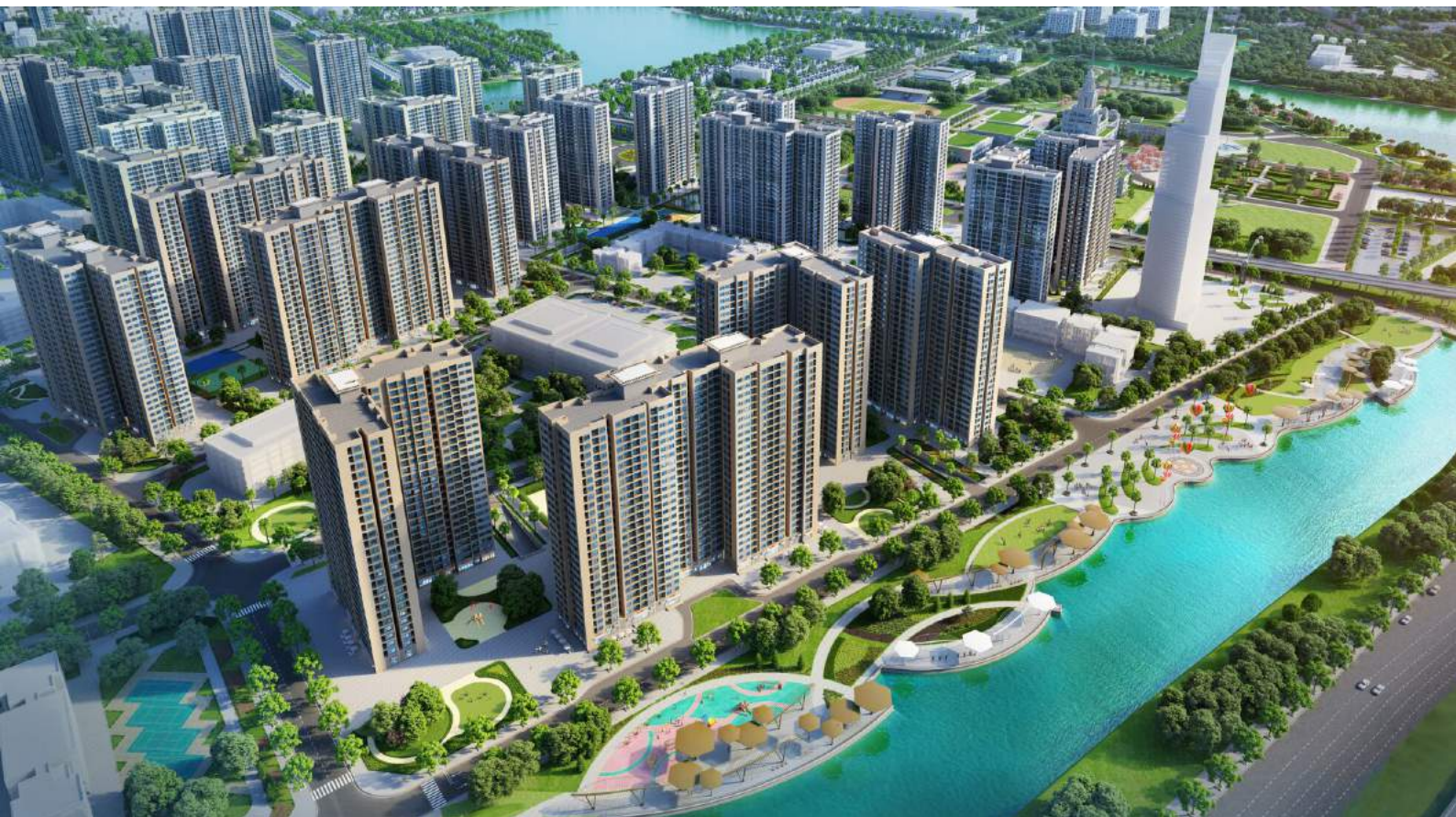
Vincity Ocean Park - Hà Nội - Cung cấp và lắp đặt cửa thép chống cháy - Quy mô: 2.800.000 m 2
